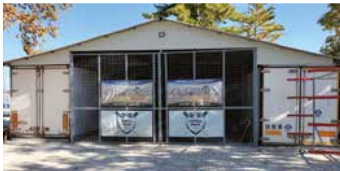
Einfach und zweckmässig: Bootshalle aus Containern mit Überdachung.
